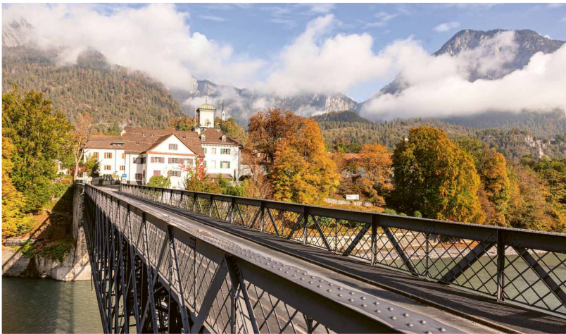
Eisenfachwerkbrücke über den Alpenrhein Iron truss bridge over the Alpine Rhine
